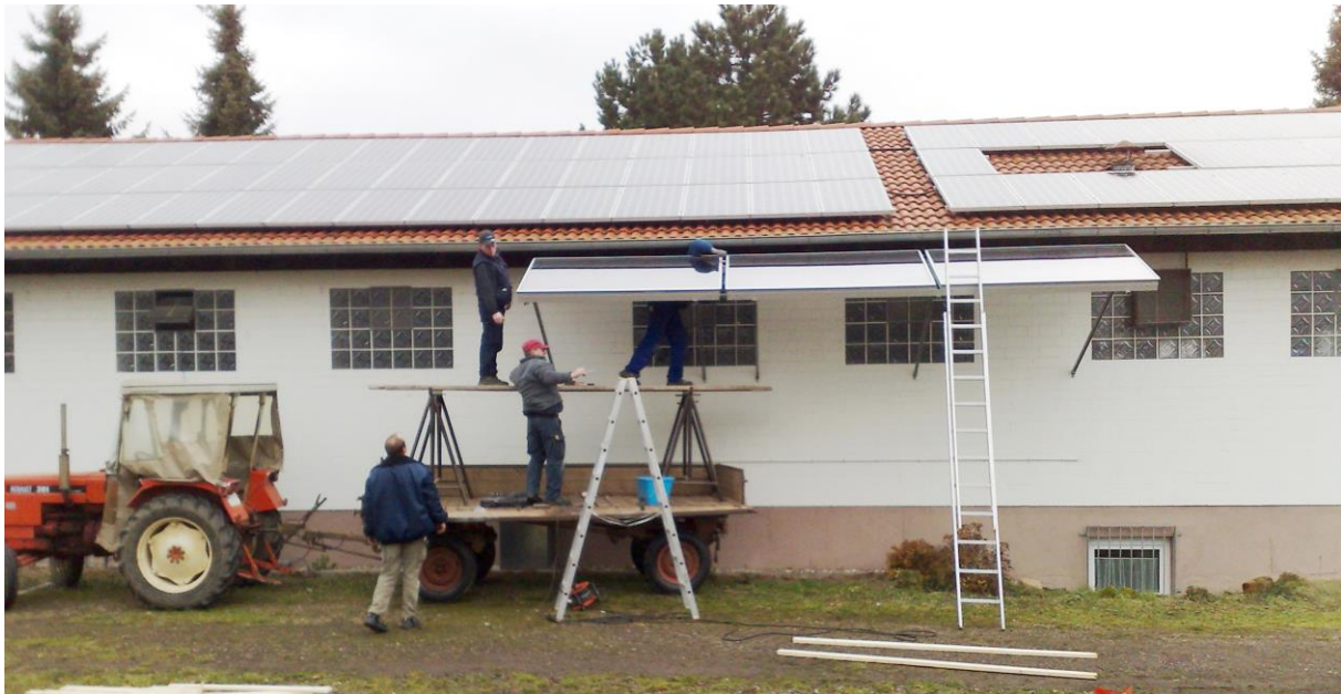
Die Installation der Photovoltaikanlage am 13.12.08
